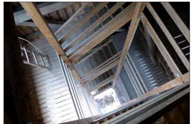
Abb. 3: Schanzenturm, mit Blick nach unten
