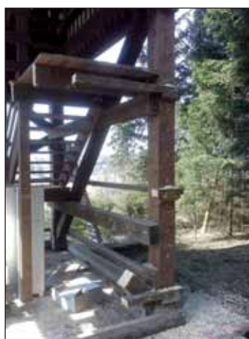
Abb. 5: Vorbereitungsarbeiten am Schanzenturm
