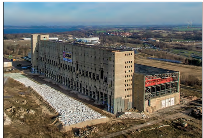
Abb. 1: Bunkerschwerbau mit Maschinenhaus
