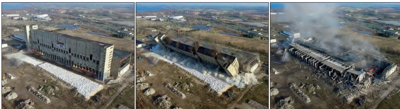
Abb. 5: Sprengung des Bunkerschwerbaus mit Maschinenhaus
