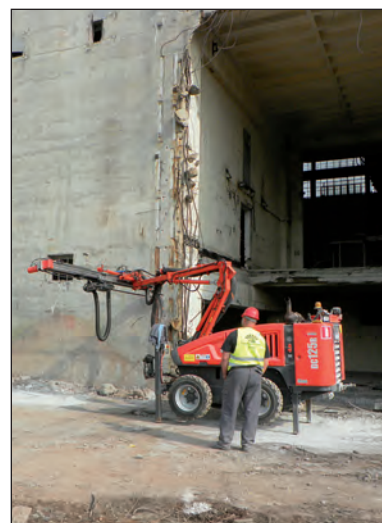
Abb. 6: Bohrarbeiten an den zu sprengenden Stahlbetonstützen des Bunkerschwerbaus
