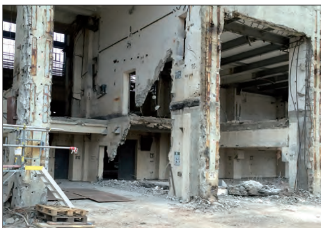
Abb. 3: Zu sprengende Stahlbetonstützen mit keilförmig ausgebrochener Querwand
