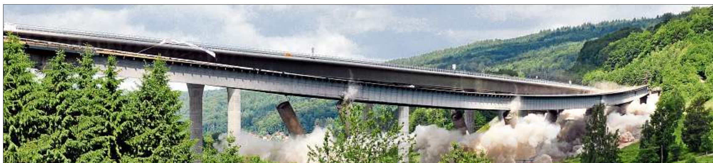
In weniger als fünf Sekunden hat die Thüringer Spreng GmbH im Juni 2013 die Sinntalbrücke der A 7 bei Bad Brückenau gesprengt. Die besondere Schwierigkeit bestand dabei auch darin, dass die neue Brücke bereits direkt daneben stand und natürlich keinen Schaden nehmen durfte. Foto: Thüringer Spreng GmbH
